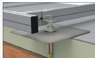
GEÏSOLEERD DAK HOUTEN PLAATMATERIAAL
